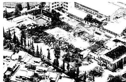
焼失した校舎の全景
